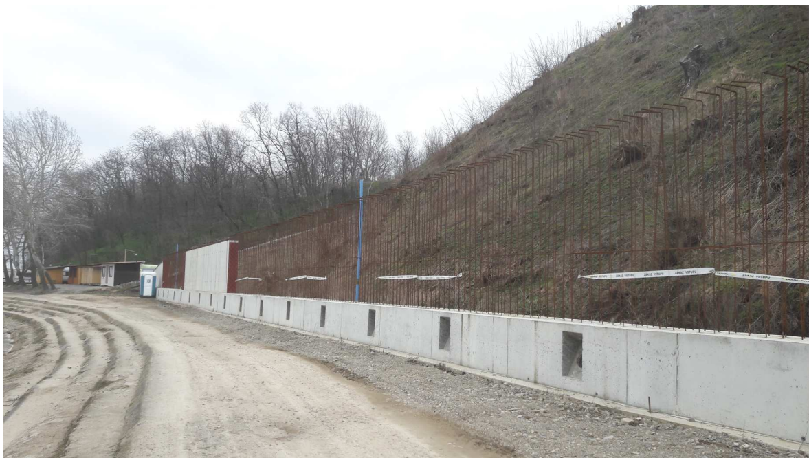
Obr. 2: Realizovaná trámová převážka a připravená výztuž pro betonáž opěrné zdi. Prostupy pro nerealizované kotvy zůstanou otevřeny pro případnou migraci vody.
