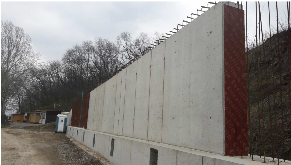
Obr. 1: Realizované prvky opěrné zdi
