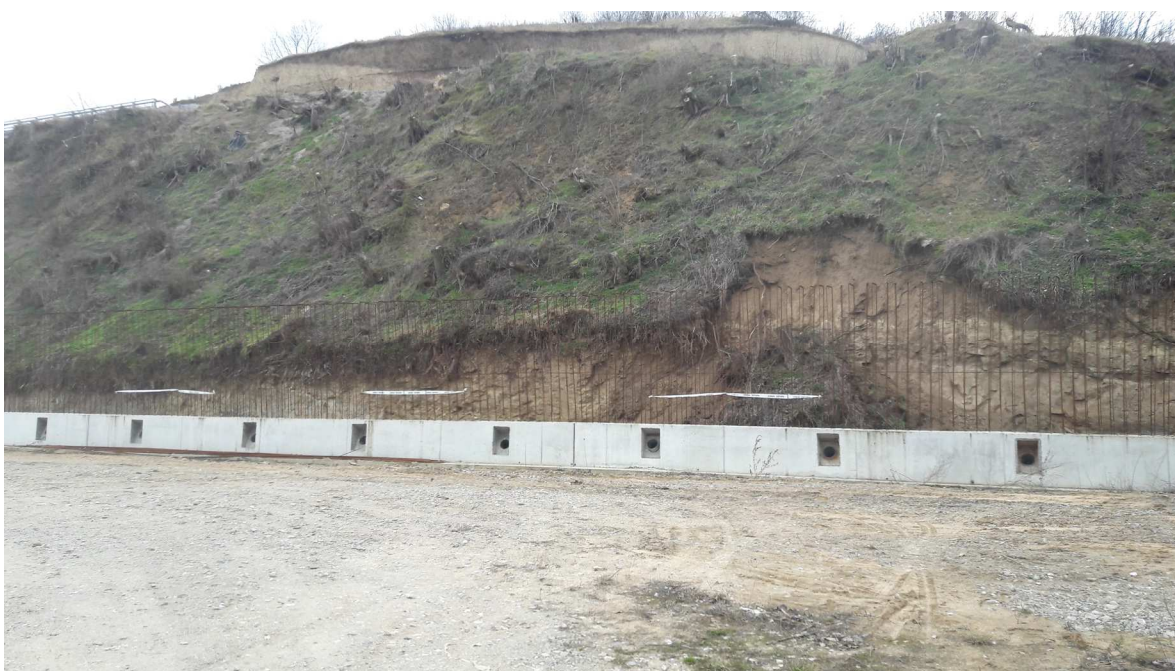
Obr. 4: Povrchové vrstvy složené z ornice a navážek občasně opadávají do výkopu. Svah bude srovnán a ornice s nestabilní navázkou a organickým materiálem odvezeny.
